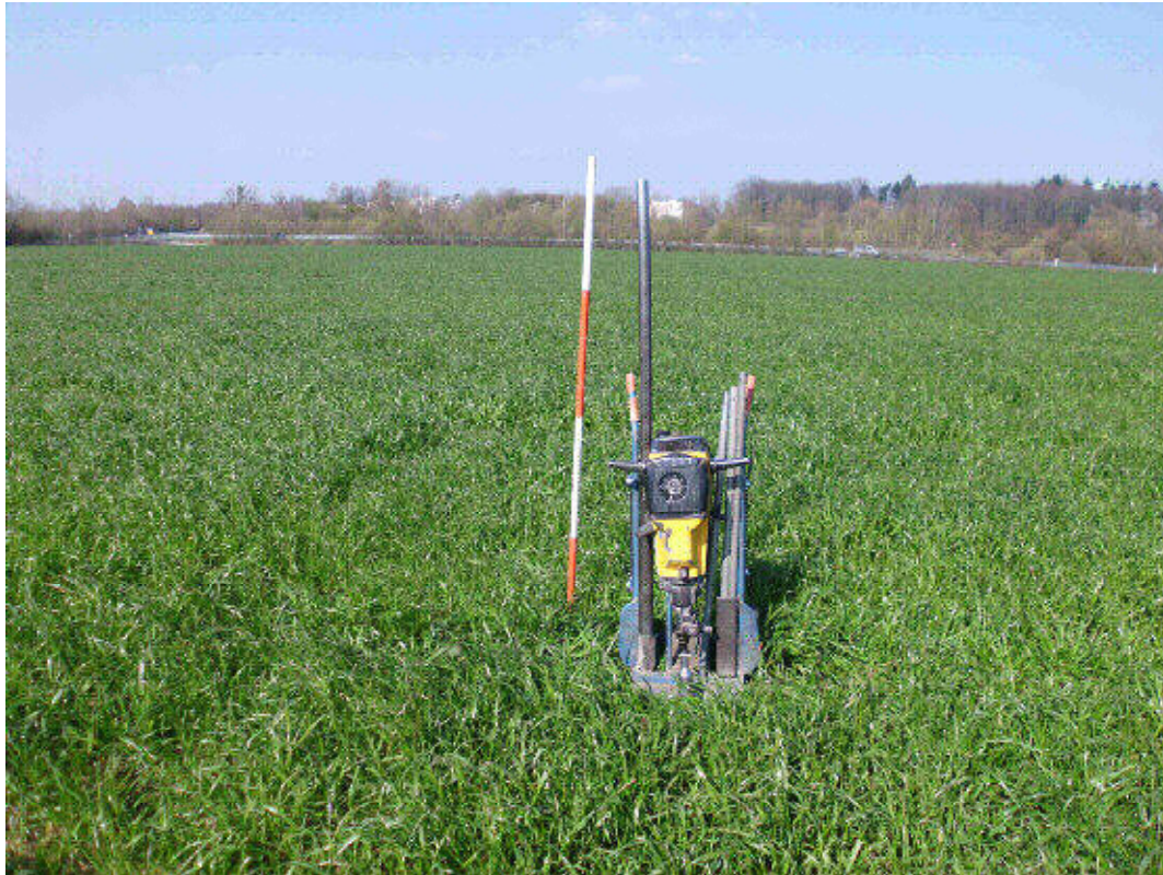
Bild 5: SE-Seite Gebäude, Sondierung S 5, Blick nach Norden
