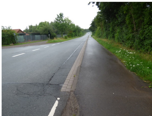
Abb. 16 Straße „Hasengarten“ westlich des Plangebietes.
