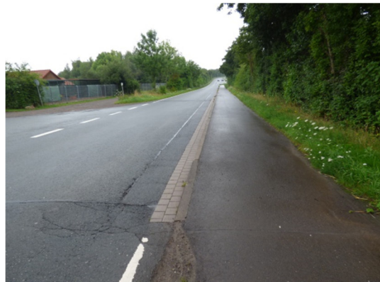
Abb. 16 Straße „Hasengarten“ westlich des Plangebietes.
